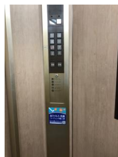
施工済みシール(安芸)
